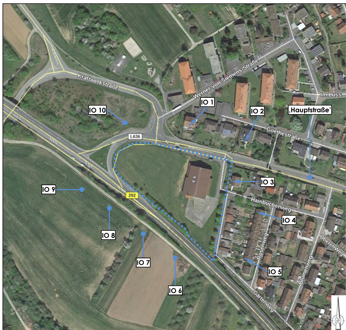
Abb.2: Luftbild des Plangebietes (.....) und der Umgebung
